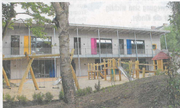
An der Stelle, wo vor zwei Jahren eine Kita mit Schimmelbelastung stand, ist nun die neue Kindertageseinrichtung Georg-Pfingsten-Straße eröffnet worden.
